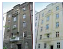
PŘED REKONSTRUKCÍ / PO REKONSTRUKCÍ
