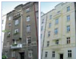
PŘED REKONSTRUKCÍ / PO REKONSTRUKCÍ
